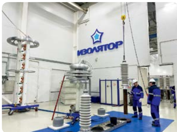
Испытательная станция 10–150 кВ
