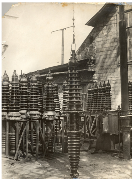
Рис. 2. Одни из первых полностью отечественных вводов класса напряжения 110 кВ
