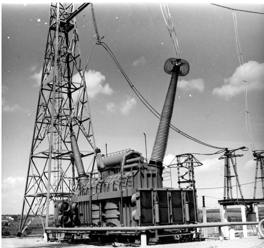
Рис. 4. Однофазный автотрансформатор класса напряжения 1150 кВ номинальной мощностью 667 МВА с вводами «Изолятор», установленный на казахстанском участке транзита Сибирь – Казахстан – Урал (фото: архив «Мосэнерго»)
