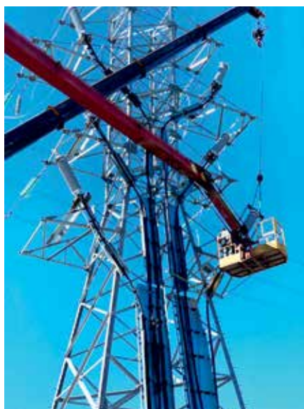
➤ Шеф-монтаж высоковольтной кабельной арматуры «Изолятор» в Карачаево-Черкесии
