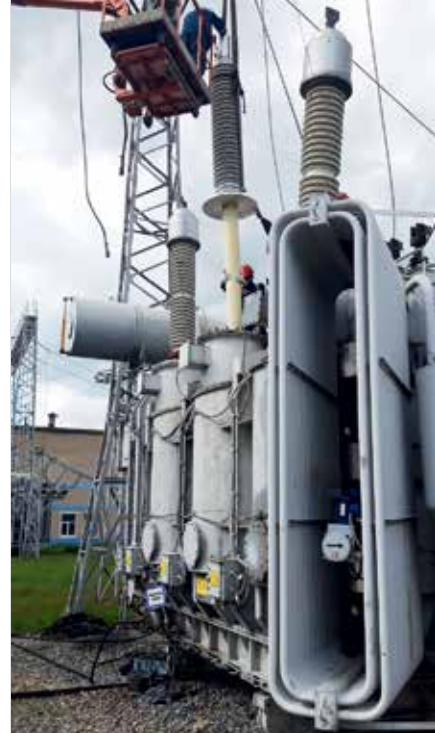
➤ Шеф-монтаж ввода 110 кВ
