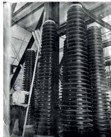
➤ Крупногабаритные фарфоровые покрышки, спроектированные и изготовленные на заводе «Изолятор». 1960-е годы
