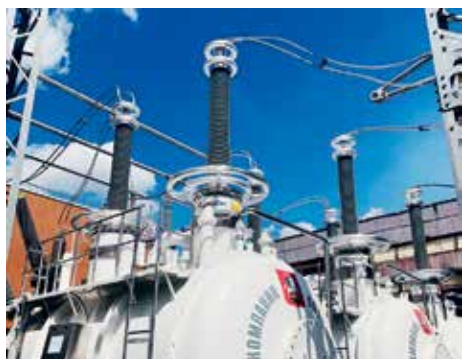
➤ Токоограничивающее устройство «СуперОкс», установленное на электрической подстанции 220 кВ «Мневники» в Москве
