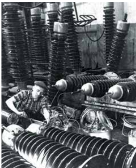
➤ Изготовление вводов 132 кВ для Асуанского гидроузла в Египте. 1966 год
