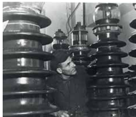
➤ Испытания вводов 220 кВ для силовых трансформаторов и масляных выключателей Каскада Свирских ГЭС. 1930-е годы
