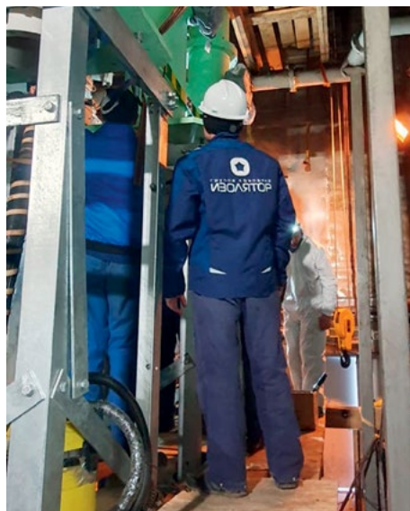
↑ Монтаж высоковольтной кабельной арматуры
