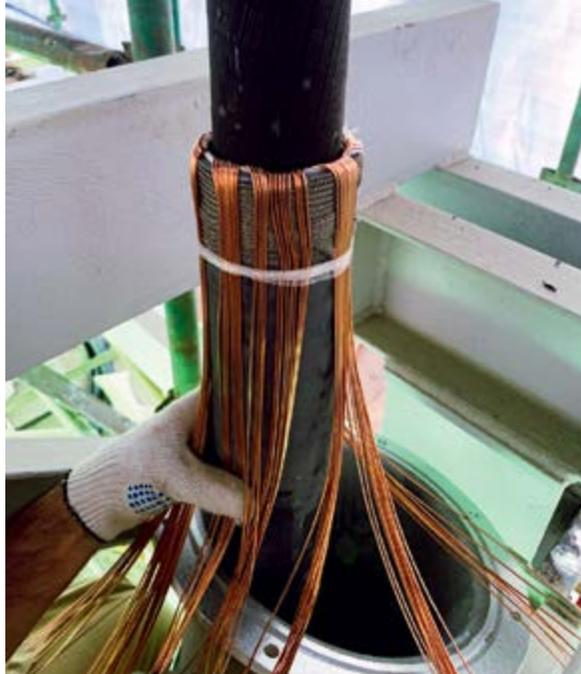
← Один из этапов монтажа — подготовка кабеля к сборке муфты
