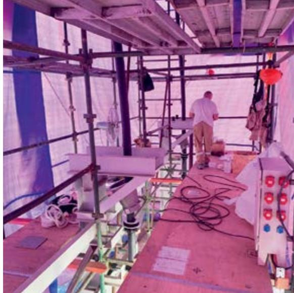
Монтажный шатер снаружи и внутри при монтаже концевых муфт ИКМ-252 на АЭС «Руппур»
