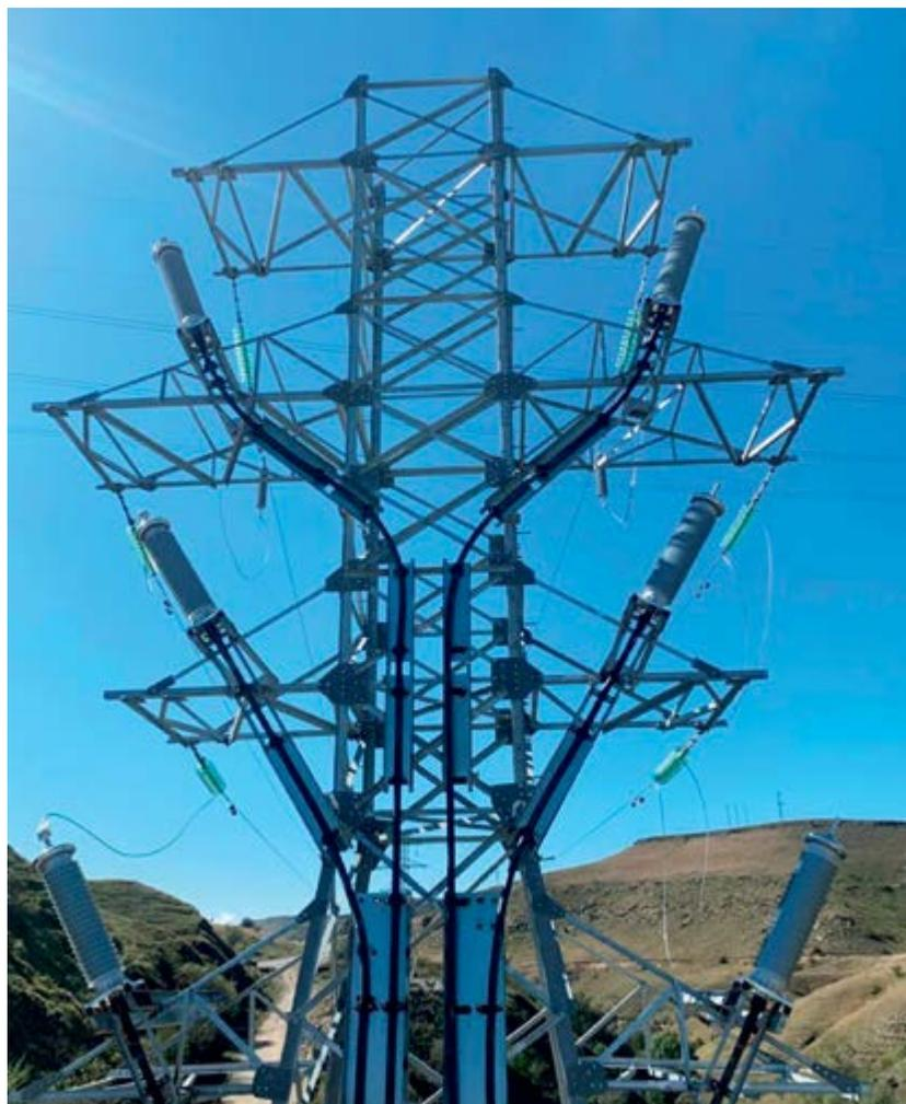
Шесть концевых кабельных муфт 110 кВ производства завода «Изолятор-АКС», смонтированных на кабельной линии Зеленчукской гидроэлектростанции — гидроаккумулирующей электростанции в Карачаево-Черкесии на Северном Кавказе
