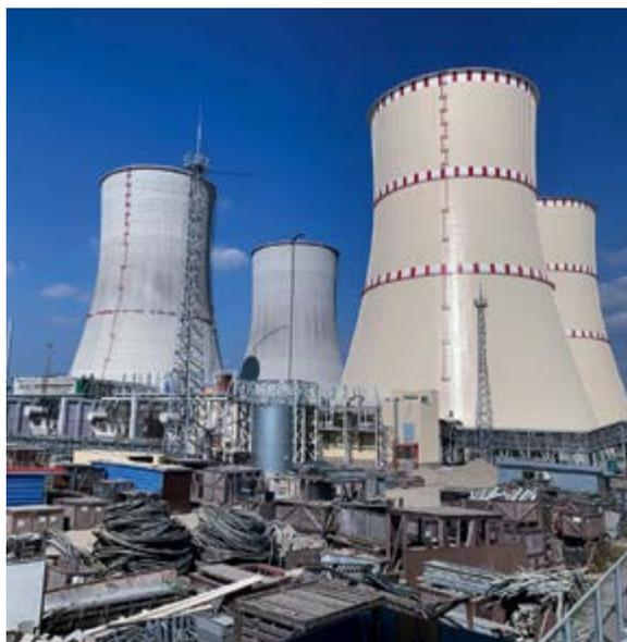
Устройства для охлаждения воды атомных реакторов (или энергоблоков). Их размеры в два раза превышают размеры аналогичных устройств на московских ТЭЦ
