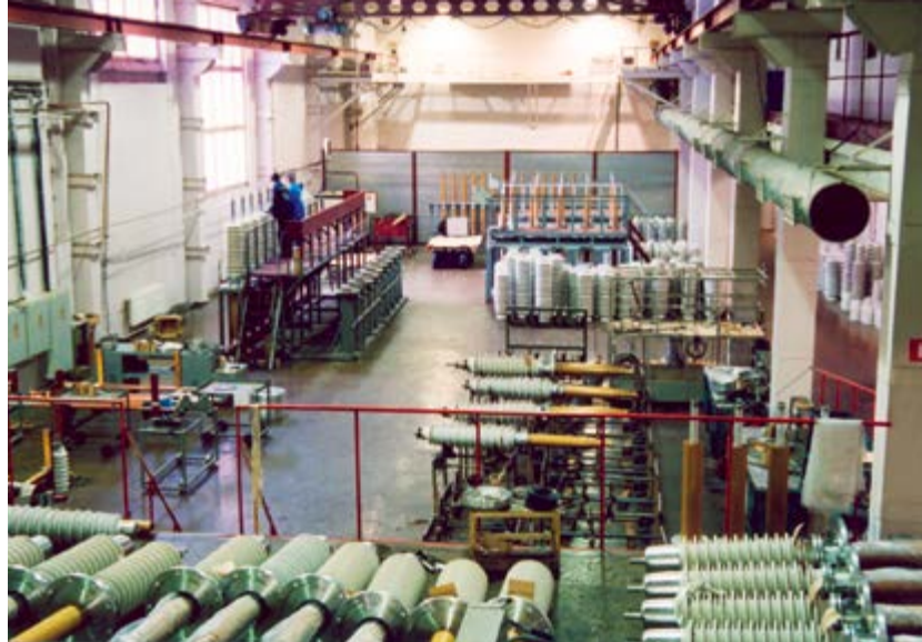
Сборка вводов 110 кВ с твердой внутренней RBP-изоляцией. Начало 2000-х годов
