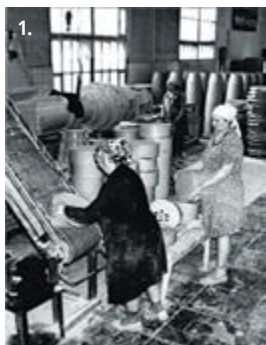
1. Вакуумная вытяжка заготовок в цехе ВВИ 2. Точильный цех. 1921 год 3. Участок сборки вводов 110 кВ
