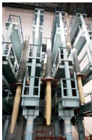
Первый в России ввод «масло — элегаз» класса напряжения 500 кВ
