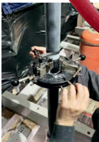
Процесс разделки кабеля перед монтажом муфты
