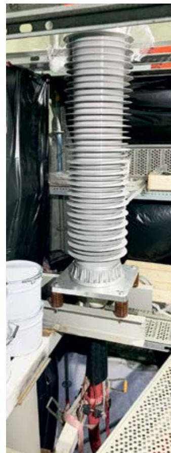
Монтаж покрывки на стресс-конусе
