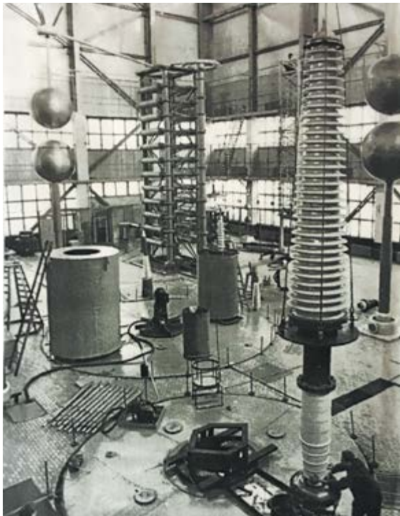
Ввод с бумажно-масляной изоляцией в высоковольтной лаборатории. 1970-е годы
