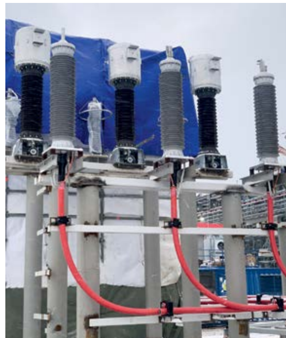
Смонтированная концевая муфта
