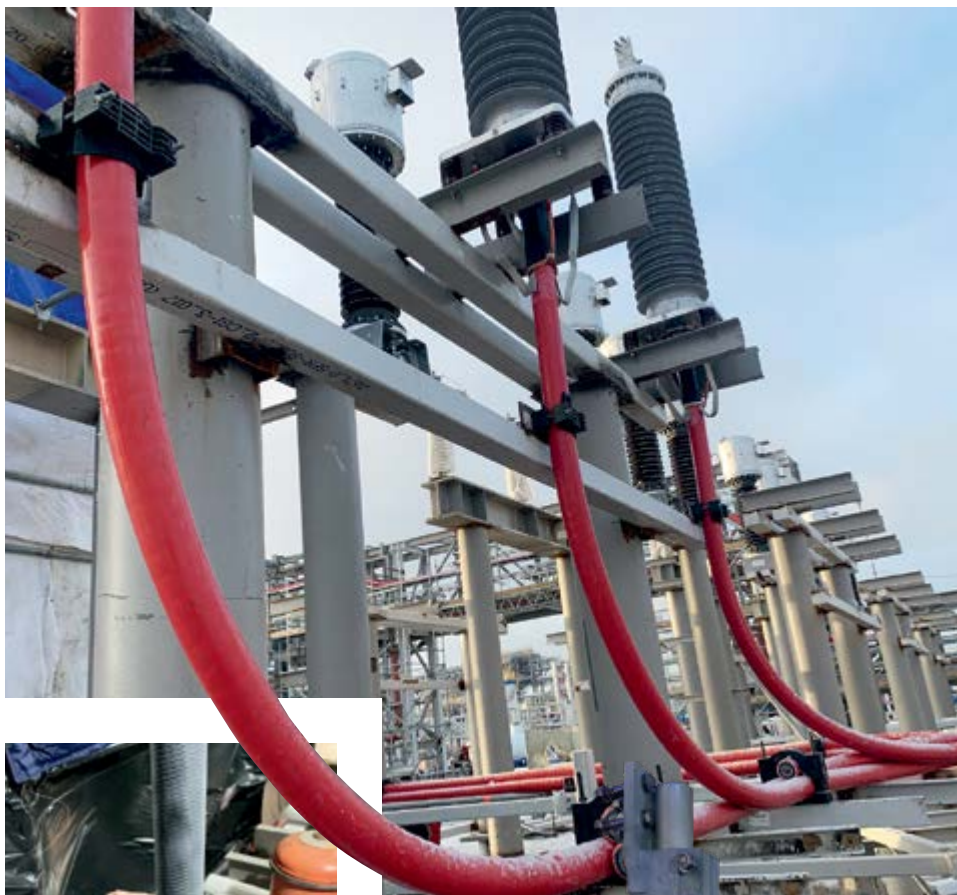
Верхняя часть покрывки с аппаратным зажимом
