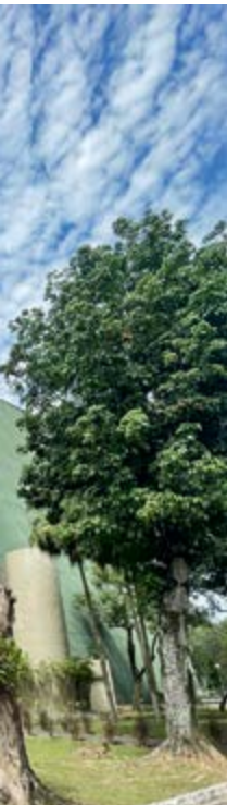
Здание испытательной лаборатории Центра исследований в области электроэнергетики Serel
