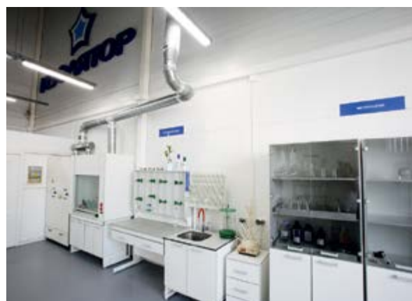
Зоны текущего контроля и метрологии, оборудованные в строгом соответствии с требованиями охраны труда
