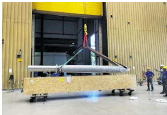
Процесс распаковки ввода с RIP-изоляцией
