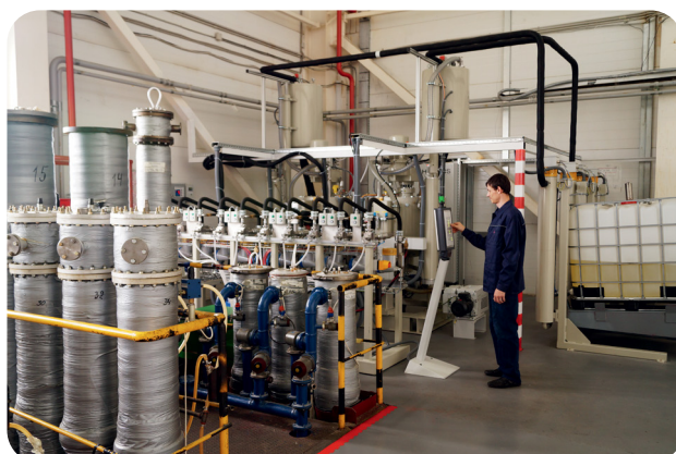
Рис. 14. Вакуумная пропитка основной изоляции
