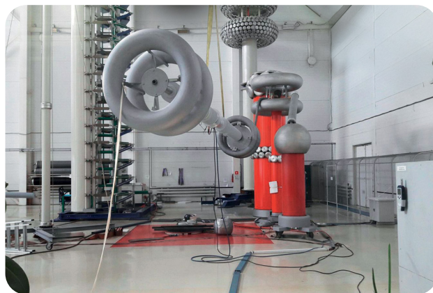
Рис. 19. Электрические испытания ввода 220 кВ
