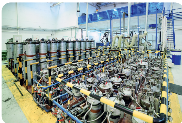
Рис. 18. Вакуумная пропитка основной изоляции
