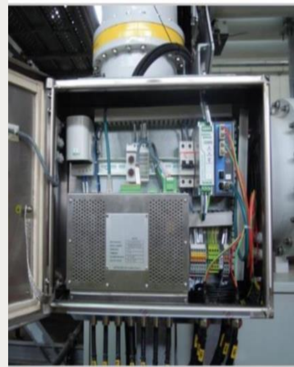
Рис. 2 Пример системы сбора данных Расположенной рядом с местом расположения датчика в ГИС
