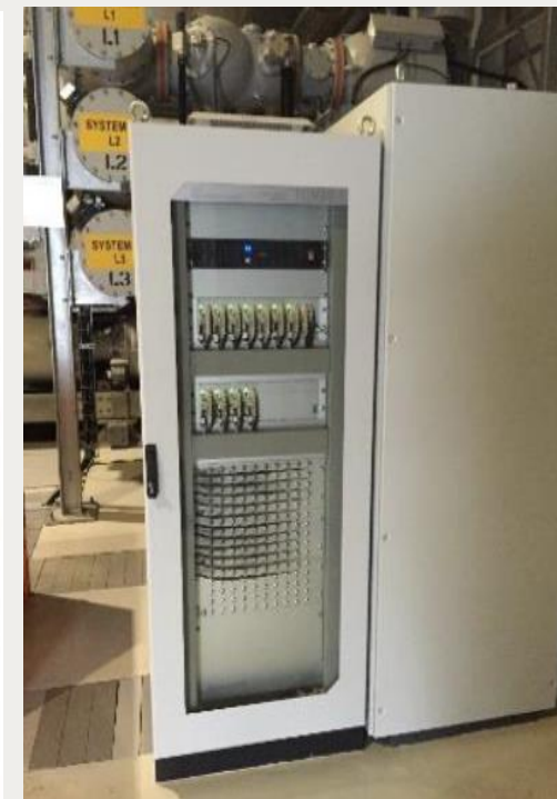
Рис. 3 Внутренняя система PDM со 120 входными каналами
