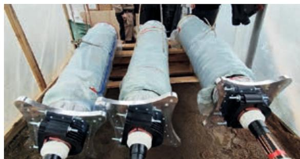
Муфта в специальном фиксирующем устройстве, подготовленная к подъему
