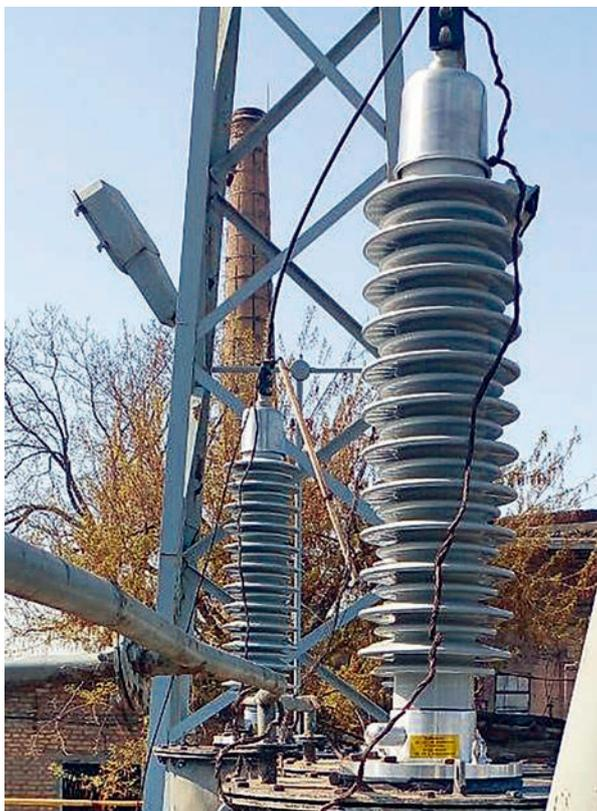
Вводы «Изолятор» класса напряжения 110 кВ с твердой внутренней RIP-изоляцией, установленные на трансформаторе подстанции предприятия Uzkaebel взамен устаревших аналогов
