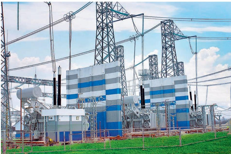
Группа однофазных силовых автотрансформаторов класса напряжения 750 кВ номинальной мощностью 1251 МВА на подстанции 750 кВ «Грибово» «Магистральных электрических сетей Центра», одной из подстанций схемы выдачи мощности энергоблока № 4 Калининской АЭС (фото: «Россети ФСК ЕЭС»)
