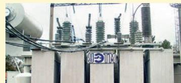
Силовой масляный трансформатор «Уралэлектротряжмаш» класса напряжения 110 кВ с высоковольтными вводами «Изолятор» (фото: «Уралэлектротряжмаш»)
