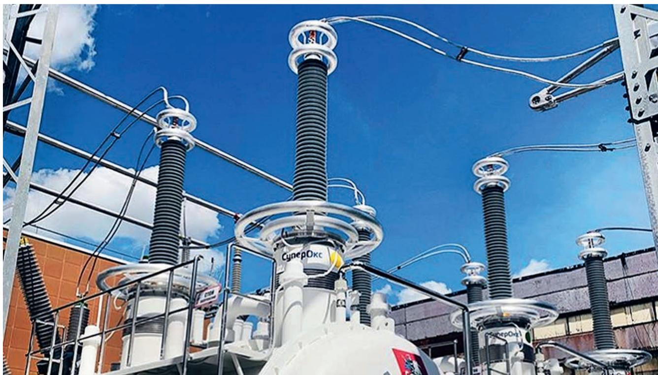
Вводы «Изолятор» класса напряжения 220 кВ с внутренней RIN-изоляцией на высокотемпературном сверхпроводниковом токоограничивающем устройстве «СуперОкс», установленном на электрической подстанции «Мневники» в Москве
