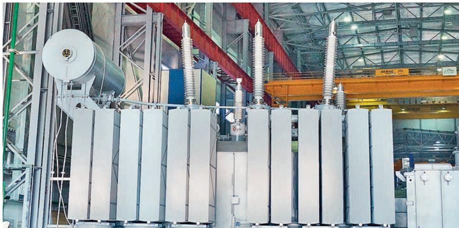
Трансформатор СМТТ мощностью 250 МВА с высоковольтными вводами «Изолятор», изготовленный для «ФСК ЕЭС» (фото: energybase.ru)
