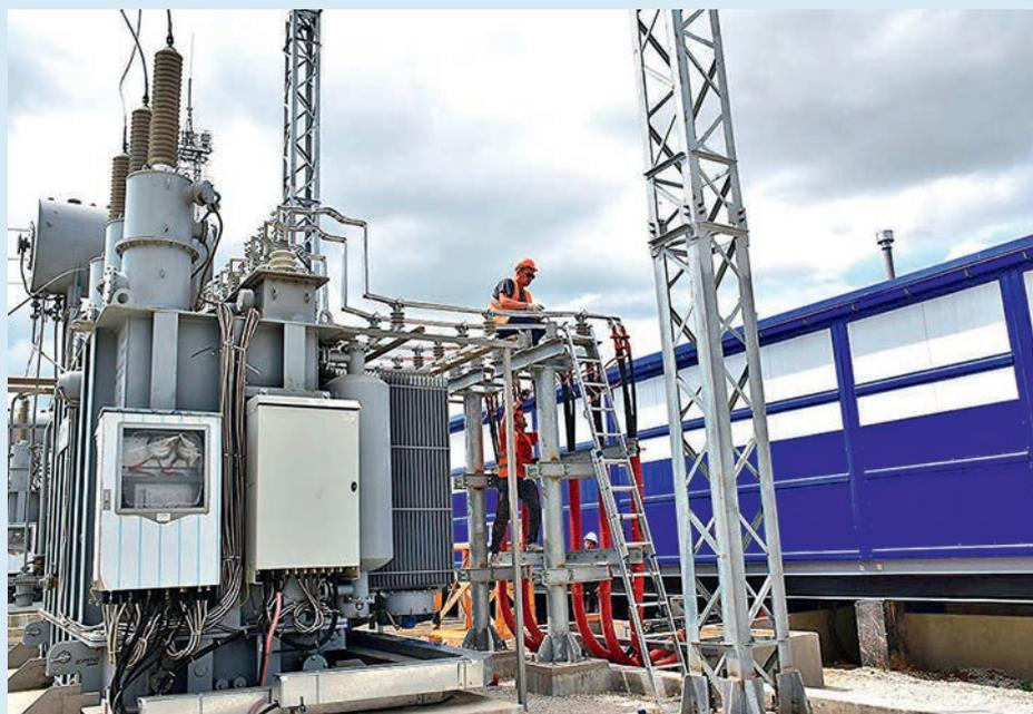
Подстанция 110 кВ «Аэропорт» компании «Крымэнерго». На трансформаторе установлены вводы «Изолятор» (фото: «Крымэнерго»)
