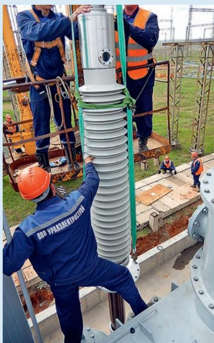
Монтаж ввода «Изолятор» 220 кВ с внутренней RIN-изоляцией на автотрансформаторе МЭС Урала
