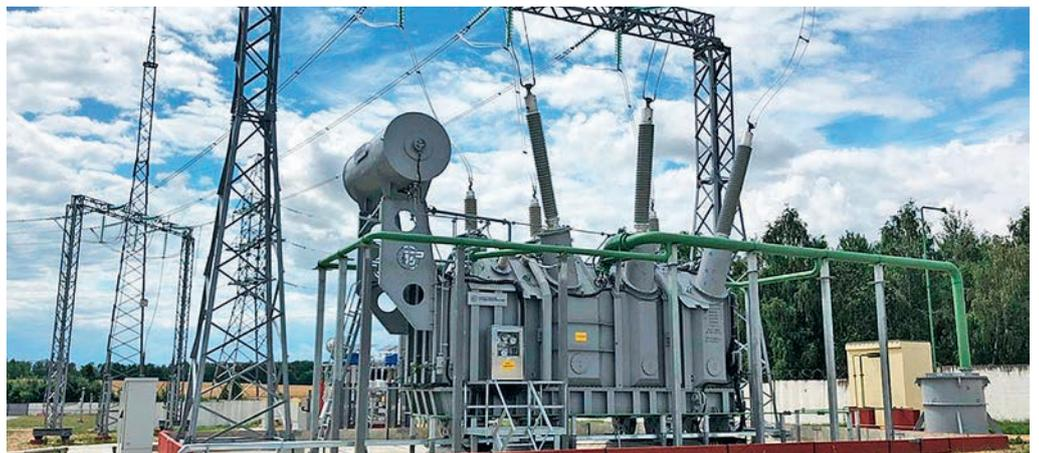
Автотрансформатор мощностью 200 МВА с высоковольтными вводами «Изолятор» на подстанции 330 кВ «Барановичи» в Белоруссии
