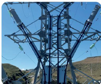
Муфты ИКМ-126 на кабельной линии гидроэлектростанции
