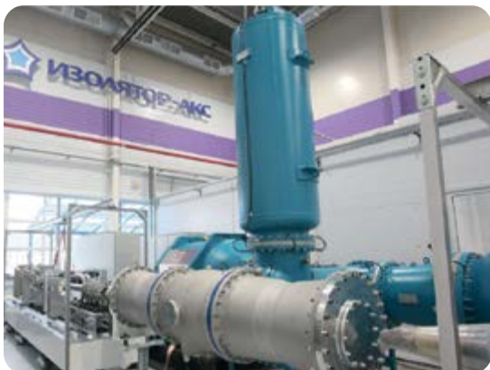
Лаборатория для приемо-сдаточных испытаний кабельной арматуры
