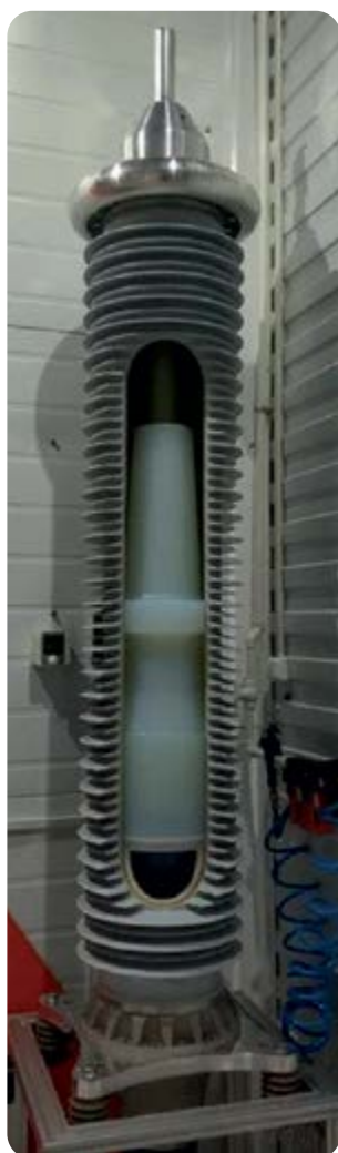
Сухая концевая муфта ИСКМ-126
