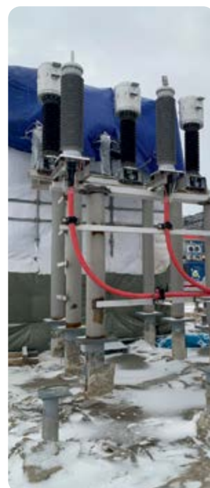
Монтаж муфт ИКМ по проекту «Арктик СПГ-2»
