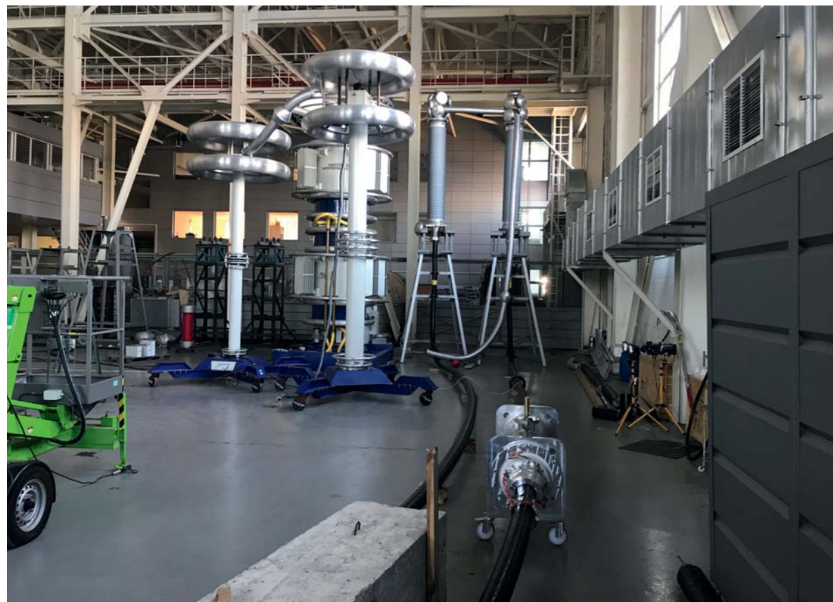
Типовые испытания кабельной арматуры «Изолятор» класса напряжения 220 кВ в испытательном центре Всероссийского научно-исследовательского проектно-конструкторского и технологического института кабельной промышленности в г. Подольске
