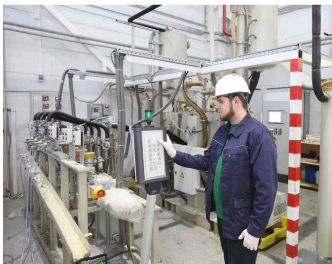
Рис.19 Вакуумная пропитка основной изоляции
