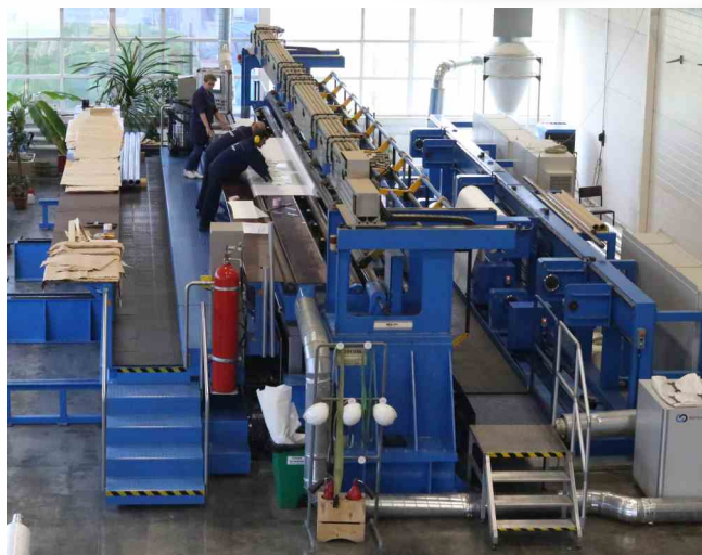
Рис.18 Высокоавтоматизированный станок для намотки основной изоляции 252-1200 кВ
