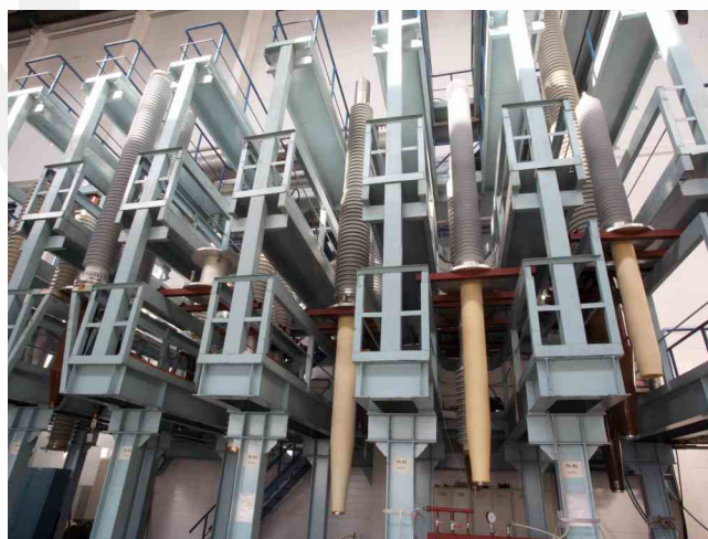
Рис.21 Вводы 500, 330 и 220 кВ с RIN-изоляцией на технологических стойках сборочного цеха
