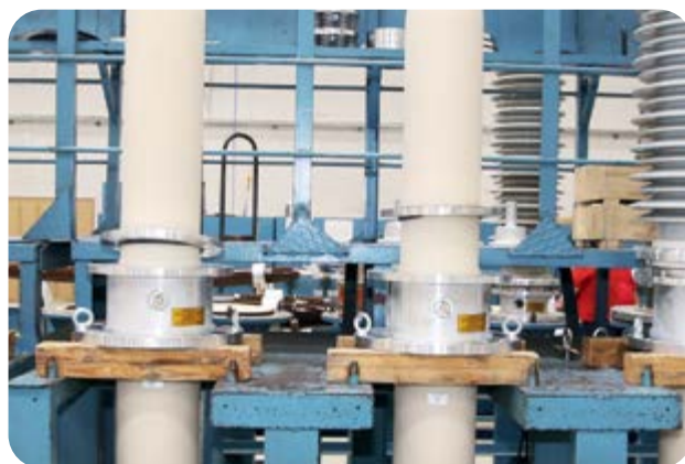
Рис. 27. Сборка вводов 110 кВ с фарфоровой внешней изоляцией
