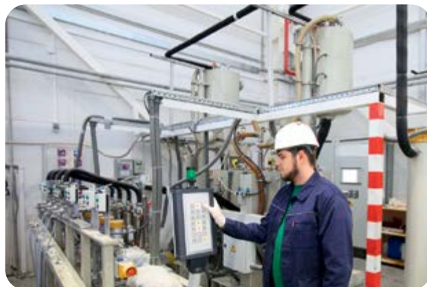
Рис. 23. Вакуумная пропитка основной изоляции
