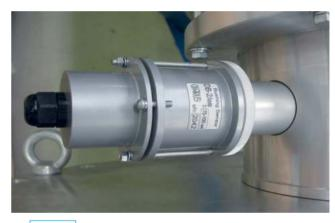
Рис.16 Датчик для защиты измерительного вывода
