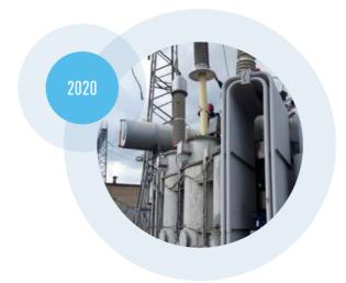
Во Владимирской области произведен монтаж первого в России ввода класса напряжения 220 кВ с твердой внутренней RIN-изоляцией для опытно промышленной эксплуатации.
