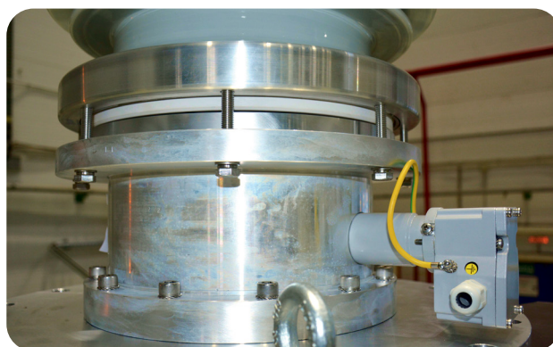
Рис. 21. Высоковольтный ввод с датчиком для защиты измерительного вывода
