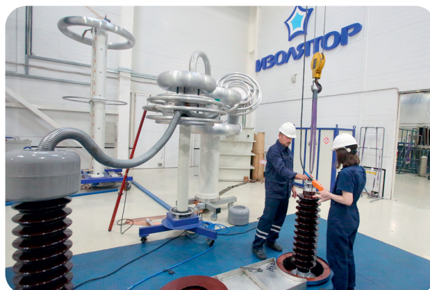
Рис. 29. Электрические испытания вводов 110 кВ
