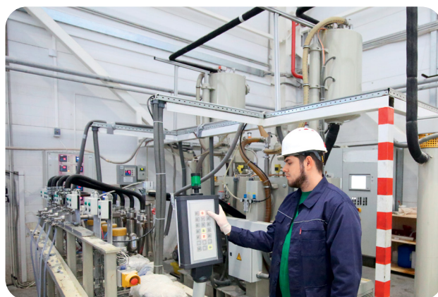
Рис. 23. Вакуумная пропитка основной изоляции
