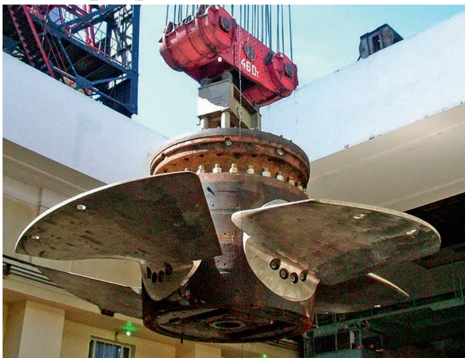
Демонтаж рабочего колеса Нижегородской ГЭС (фото: группа «РусГидро»)
