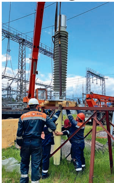
Подготовка ввода 252 кВ с RIN-изоляцией к монтажу на трансформаторе 40 МВА подстанции 220 кВ «Дальняя» во Владимирской области
