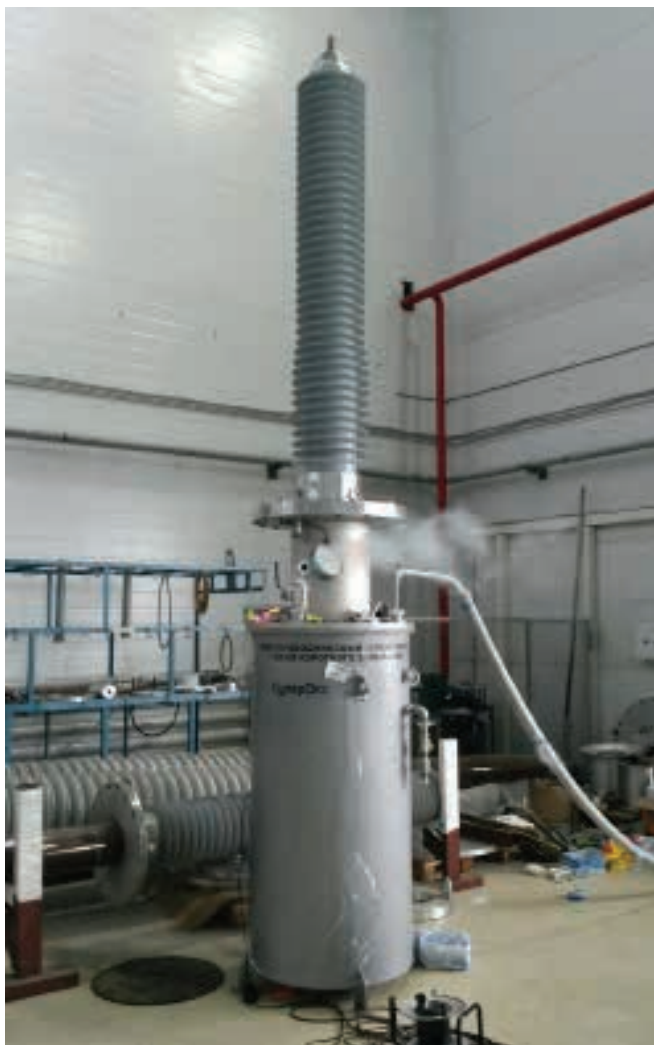
Рис. 7. Ввод 252 кВ в криостате с жидким азотом перед проведением испытаний
