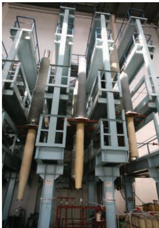
Рис. 6. Вводы 252–550 кВ на сборочном стенде
