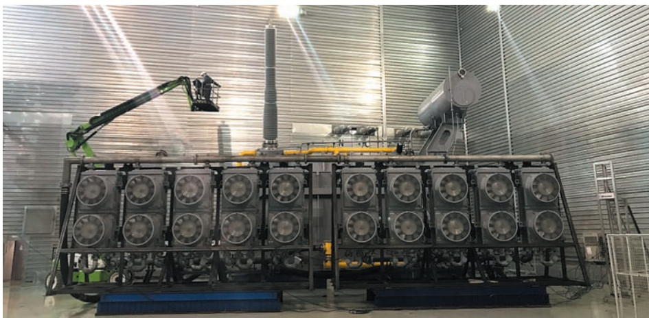
Монтаж ввода «Изолятор» 750 кВ с твердой RIP-изоляцией на трансформаторе СМТТ для Калининской АЭС
