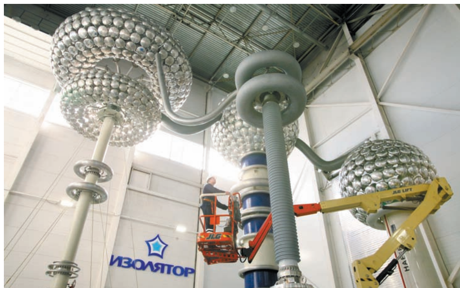
Подготовка ввода «элегаз-масло» класса напряжения 500 кВ к испытаниям на заводе «Изолятор»
