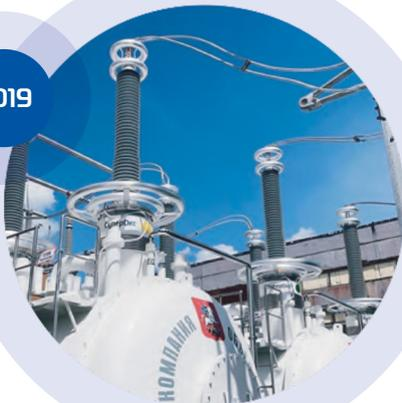
На московской подстанции 220/20 кВ «Мневники» Объединенной энергетической компании введено в промышленную эксплуатацию высокотемпературное сверхпроводниковое токоограничивающее устройство, разработанное и изготовленное компанией «Супер-Окс».
