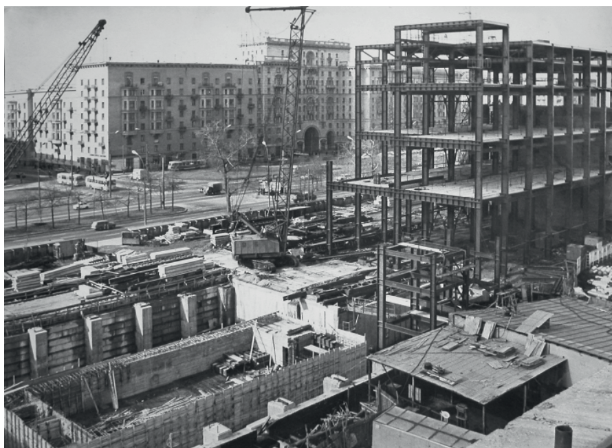
Строительство производственно-лабораторного корпуса. 1970 год
