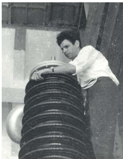
А. А. Барков на монтаже оборудования Асуанской плотины
