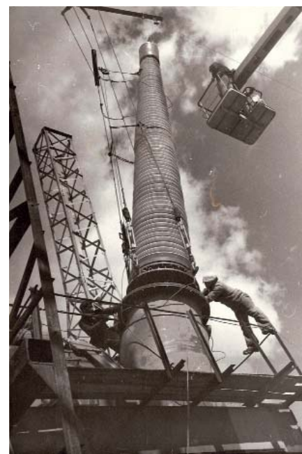
Монтаж вводов 1150 кВ. 1988 год
