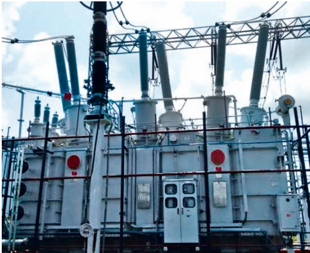
Трансформатор с вводами «Изолятор» на подстанции Vatnapuli 400 кВ в Индии
