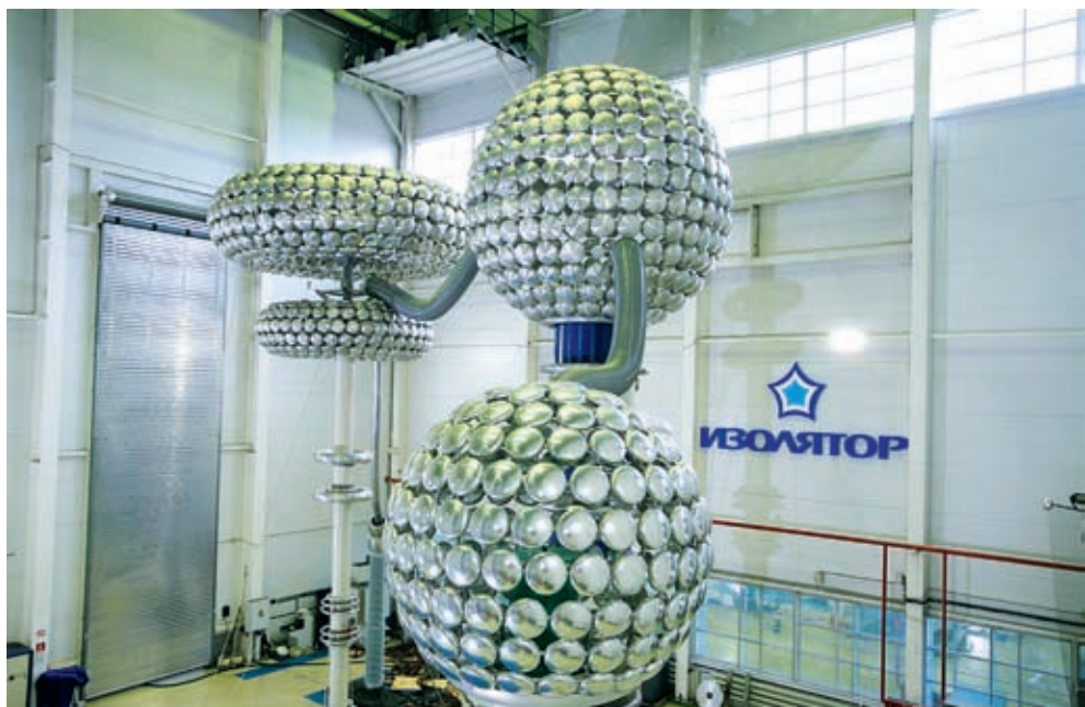
Логотип компании на испытательной станции 220–1150 кВ
