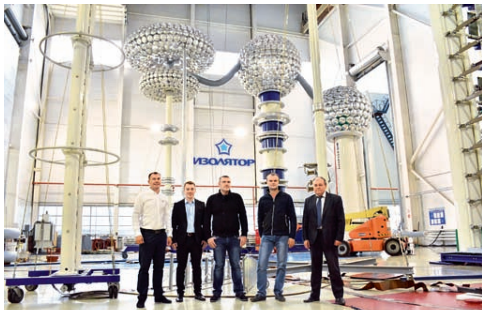
Участники инспекции испытаний высоковольтных вводов «Мозырского НПЗ» в испытательном центре завода «Изолятор»
