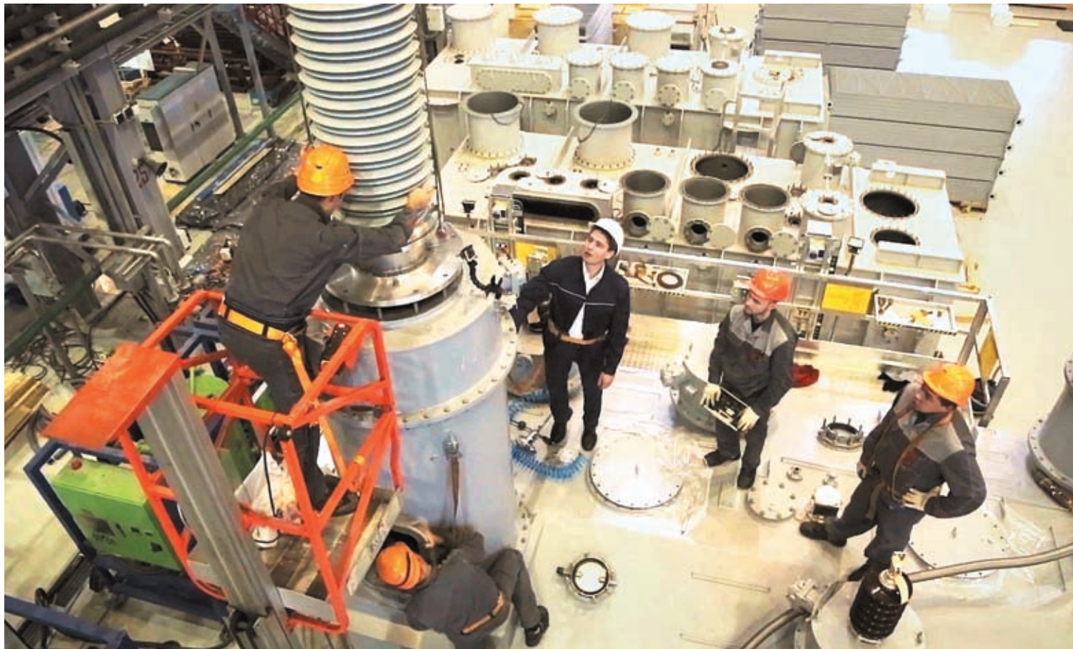
Фрагмент учебного фильма по монтажу вводов «Изолятор»
