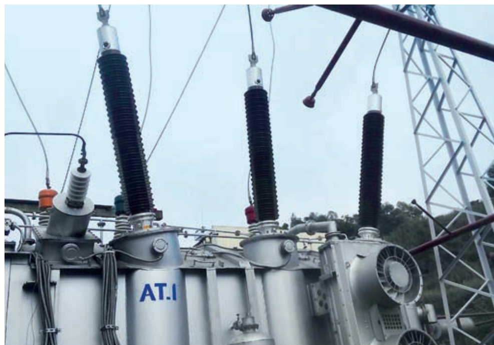
Вводы с RIP-изоляцией на напряжение 220 кВ, поставленные компанией «Изолятор» на ГЭС «Хоабинь» в 2016 году
