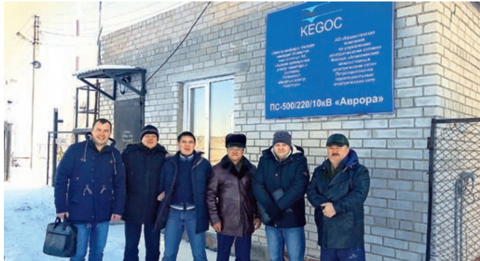
Участники семинара компании «Изолятор» на подстанции «Аврора» KEGOC
