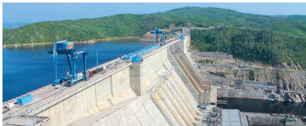
Бурейская ГЭС (фото пресс-службы ПАО «РусГидро»)
