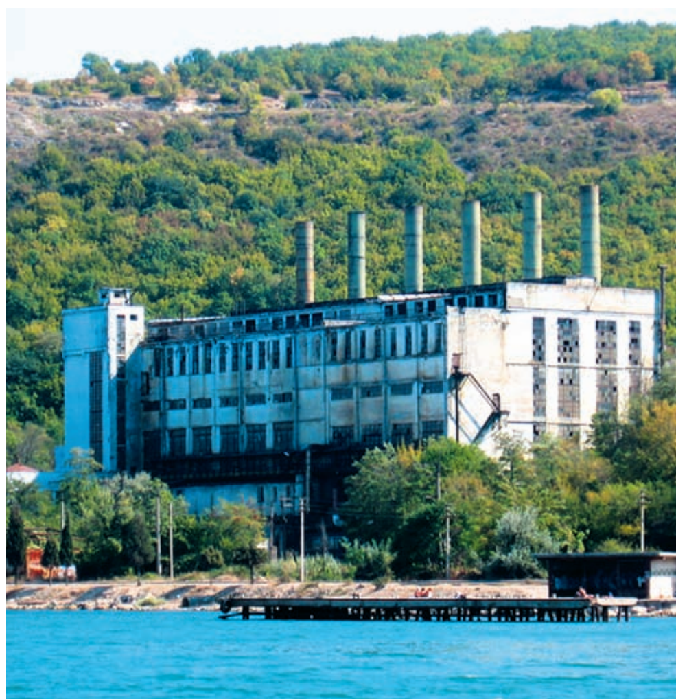
Севастопольская ТЭЦ (фото с портала «Энергосовет»)
