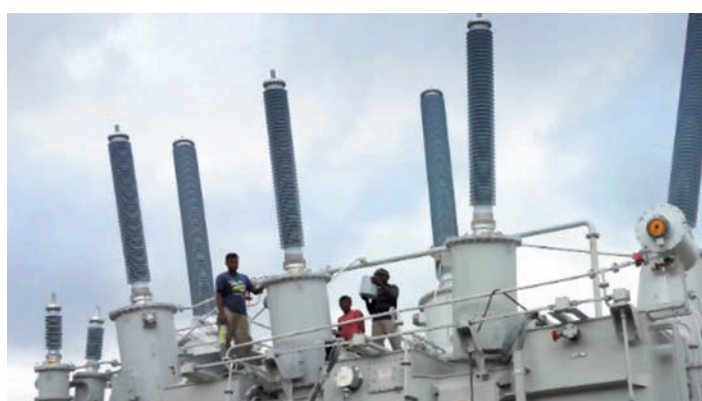
Монтаж вводов «Изолятор» на трансформаторе Vatnauli в Индии
