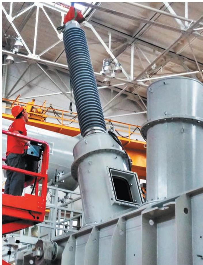
Монтаж вводов «Изолятор» на трансформаторе Группы «СВЭЛ»
