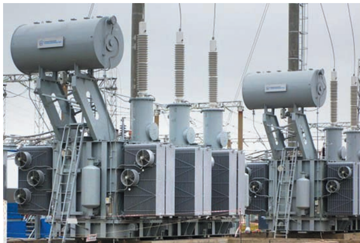
Вводы «Изолятор» на трансформаторе производства ООО «Тольяттинский Трансформатор»
