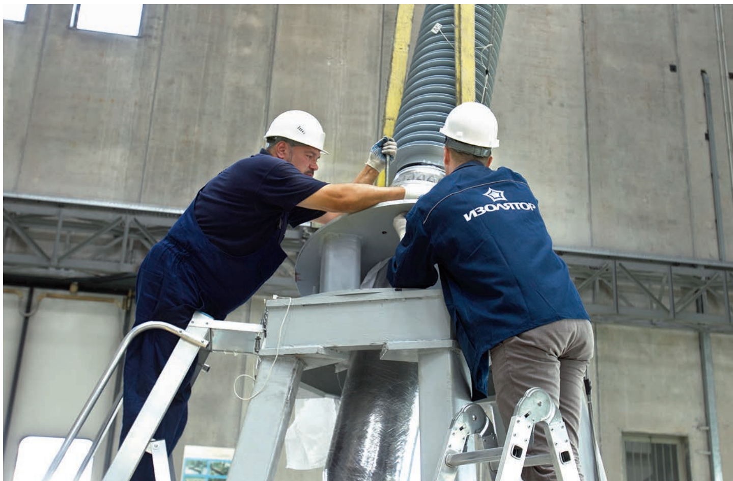
Монтаж ввода на испытательном стенде
