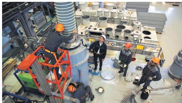
Фрагмент учебного фильма по монтажу вводов «Изолятор»
