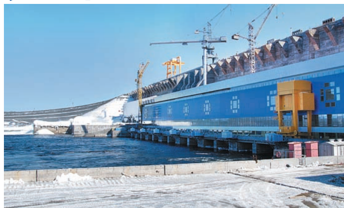
Богучанская ГЭС (фото с официального сайта ПАО «РусГидро»)
