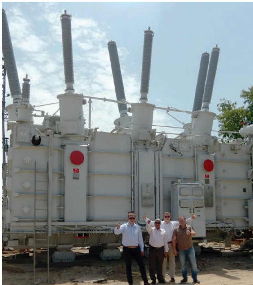
Завершен монтаж вводов «Изолятор» на первом трансформаторе на подстанции Bamnauli 400 кВ в Индии. Слева направо: Андрей Шорников, Dr. Ashok Singh, Иван Панфилов и Дмитрий Машинистов
