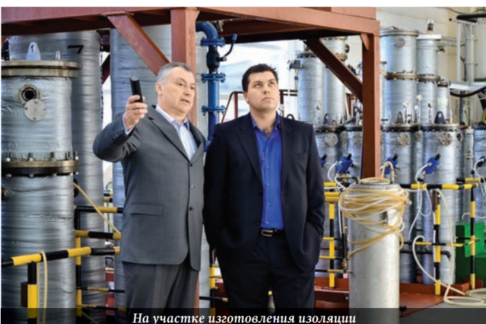
На участке изготовления изоляции
