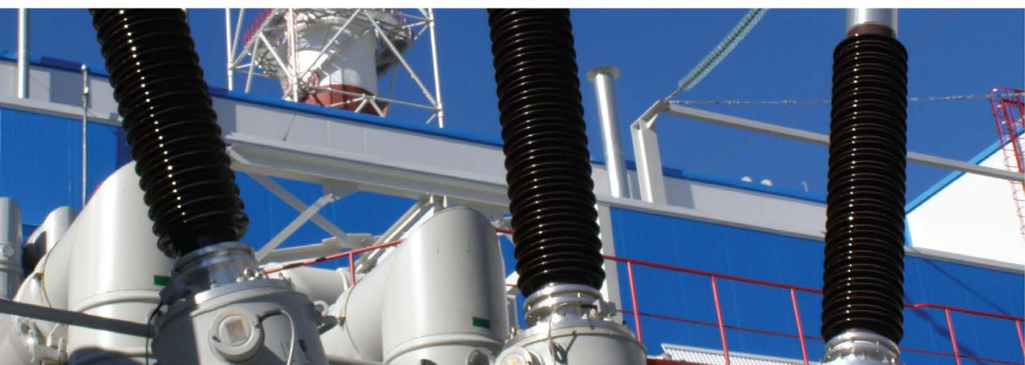
Компания «Изолятор» проектирует, производит, обслуживает и ремонтирует высоковольтные вводы переменного и постоянного тока на классы напряжения до 1150 кВ для силовых трансформаторов, шунтирующих реакторов, масляных выключателей, комплектных распределительных элегазовых устройств, а также линейные высоковольтные вводы.
