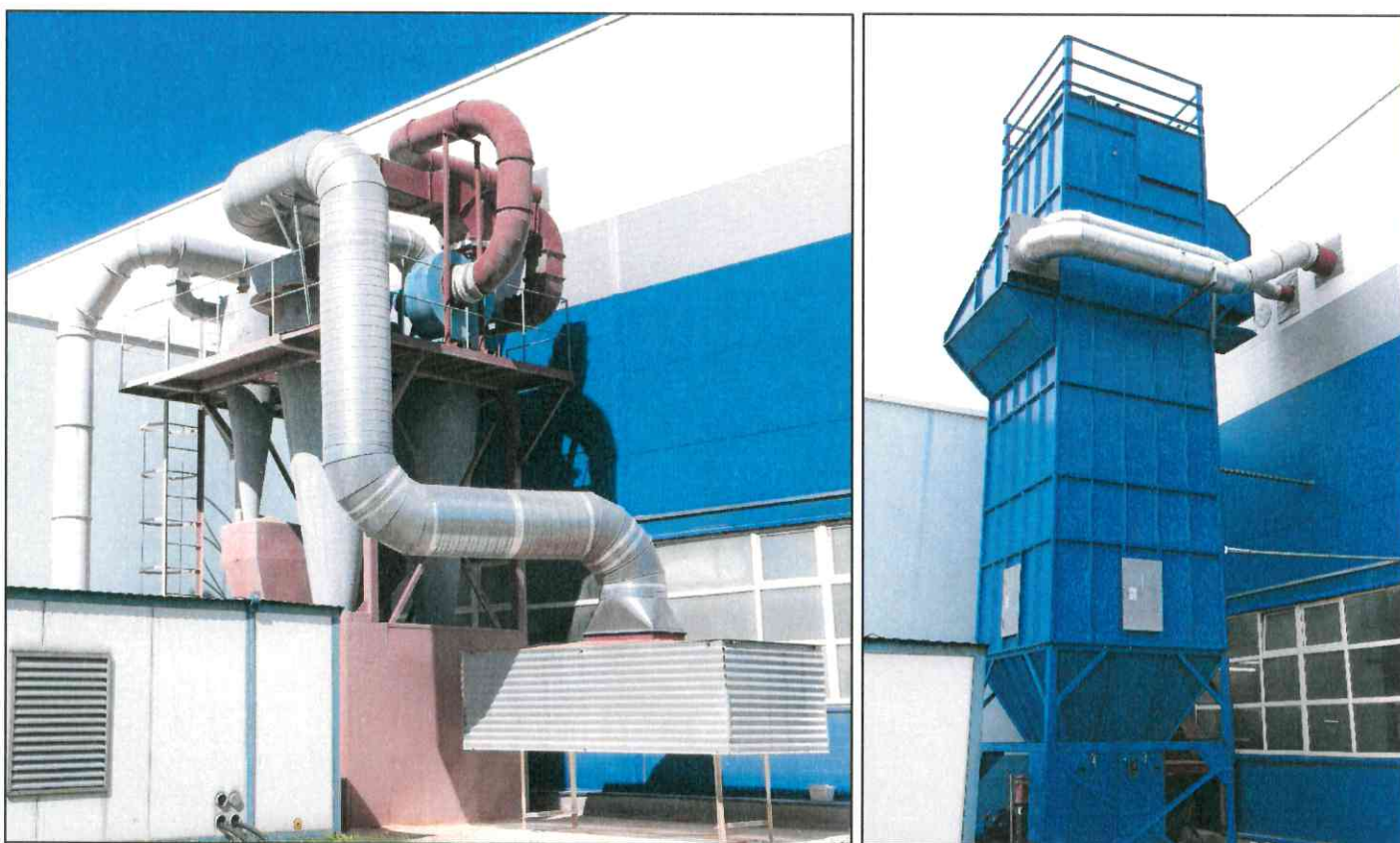
Фото 2. Демонтированные установки очистки газа типа Циклон (слева) и введённый в эксплуатацию рукавный фильтр (справа)
