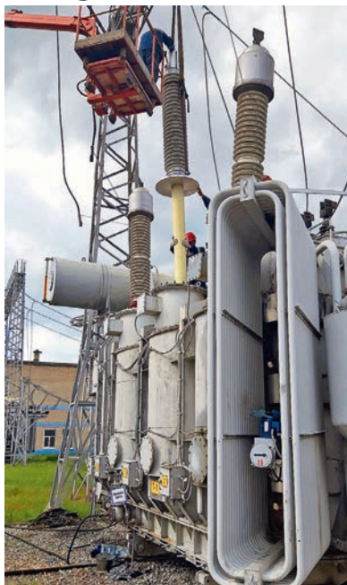
Монтаж ввода 252 кВ с RIN-изоляцией на трансформаторе 40 МВА подстанции 220 кВ «Дальняя» во Владимирской области
