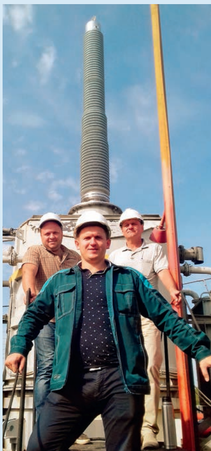
Завершен монтаж первого в Белоруссии ввода 750 кВ с RIP-изоляцией, изготовленного заводом «Изолятор», слева направо: Дмитрий Машинистов, ведущий инженер представительства компании «Рико» в Белоруссии Анатолий Терещук и начальник подстанции 750 кВ «Белорусская» Вячеслав Маскалик
