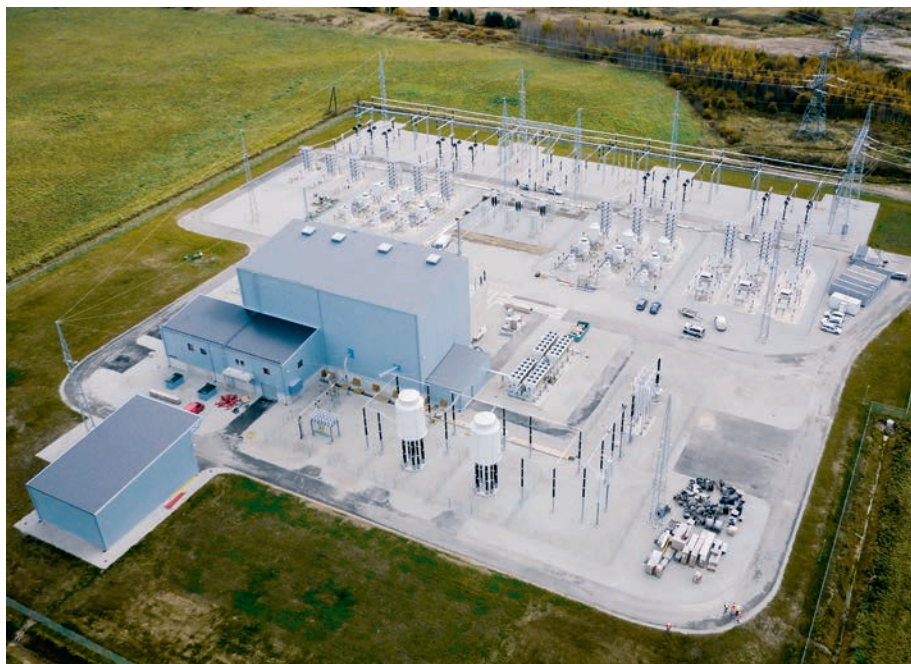
Преобразовательная подстанция передачи постоянного тока EStlink 2 (Эстония — Финляндия). Мощность 650 МВт
