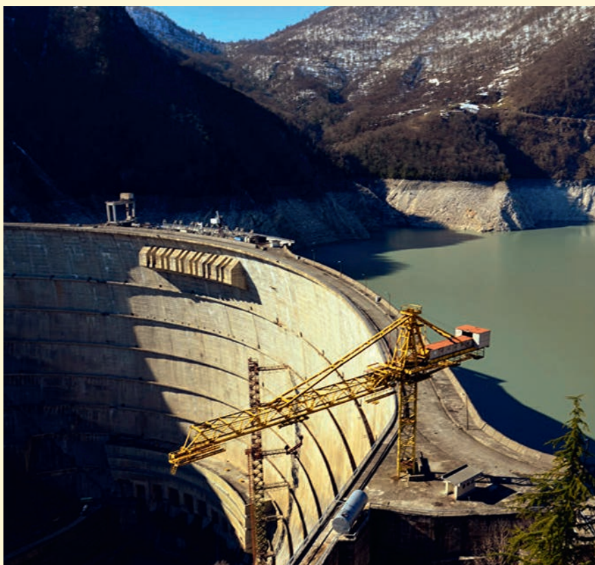
Ингурская ГЭС (Фото: Республиканское унитарное предприятие «Черноморэнерго»)
