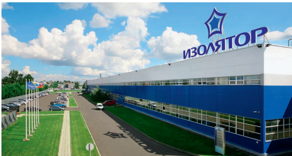
Производственный корпус компании «Изолятор»
