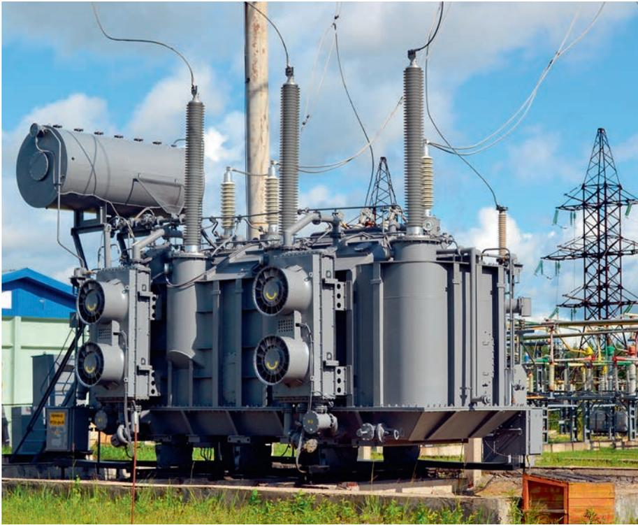
Вводы «Изолятор» классов напряжения 220 и 110 кВ на трансформаторе подстанции ФСК ЭЭС
