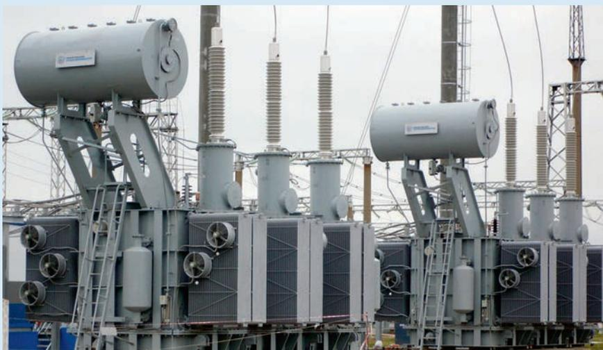
Вводы «Изолятор» 220 кВ на трансформаторах завода «Тольяттинский Трансформатор»
