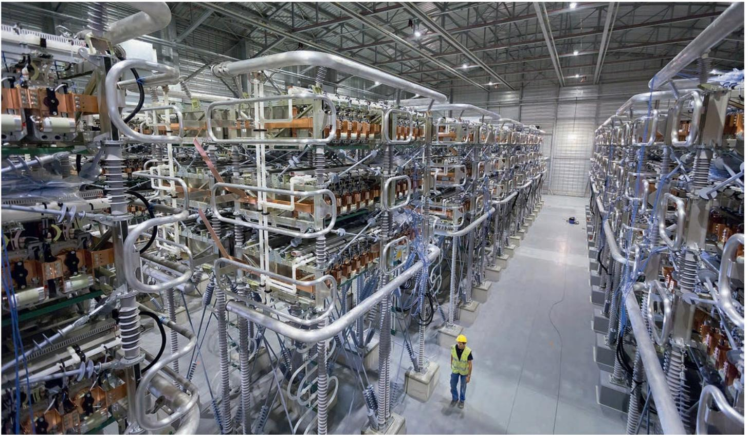
Зал выпрямительного оборудования передачи постоянного тока между Францией и Испанией. Мощность 1000 МВт на основе IGBT
