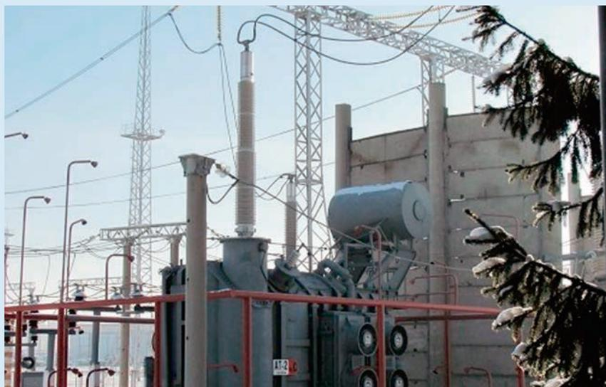
Вводы «Изолятор» классов напряжения 500 и 220 кВ на трансформаторе подстанции ФСК ЕЭС
