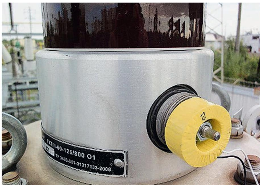
Конструкция узла присоединения к измерительному выводу со встроенным выносным трансформатором тока
