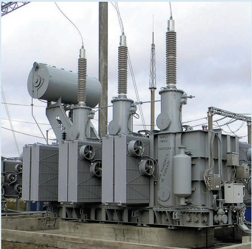
Вводы «Изолятор» на трансформаторах подстанции 220 кВ «Светлая» ФСК ЕЭС (фото: ФСК ЕЭС)
