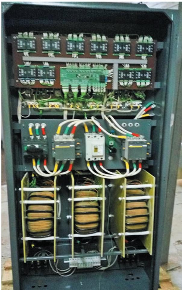
Регулятор-стабилизатор напряжения ТТРН-Б – 50/0,4 – 3
