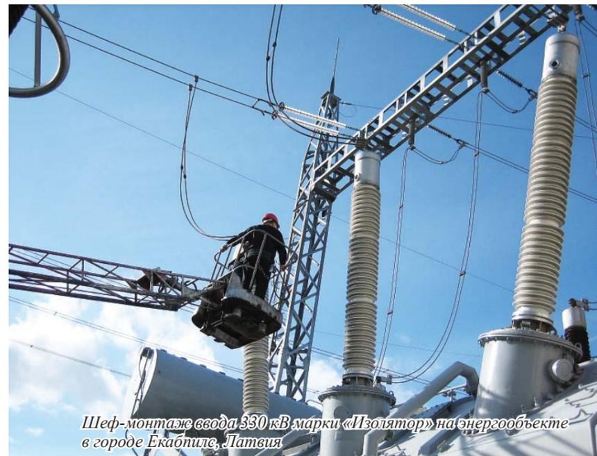
Шеф-монтаж ввода 330 кВ марки «Изолятор» на энергообъекте в городе Екабпиле, Латвия
