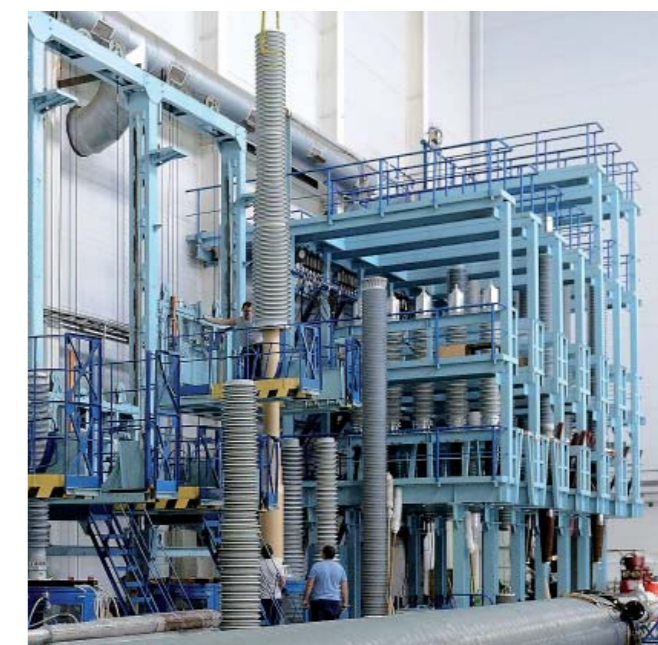
Сборочный цех высоковольтных вводов завода «Изолятор»
