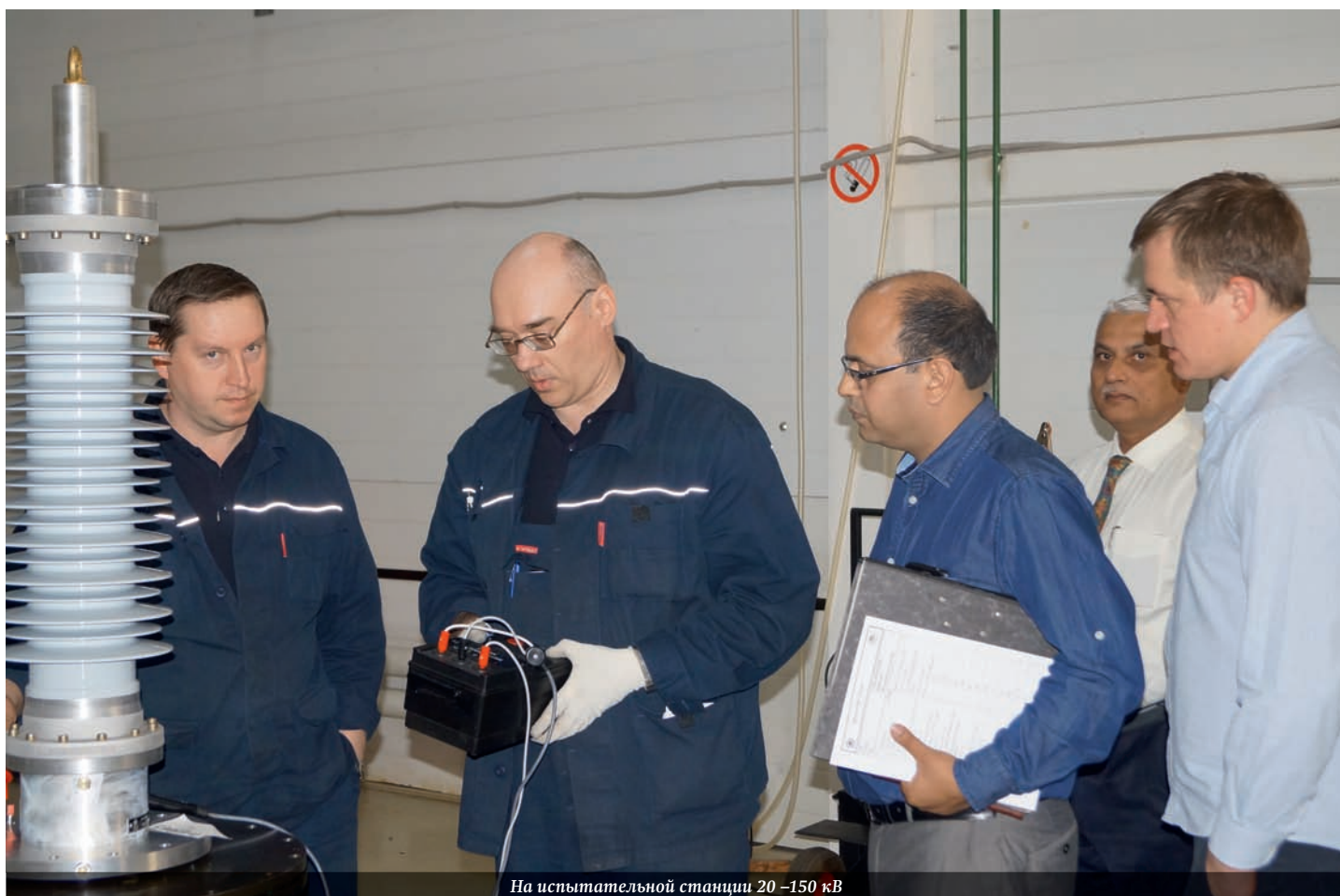
На испытательной станции 20–150 кВ
