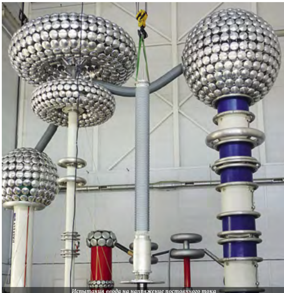
Испытания ввода на напряжение постоянного тока
