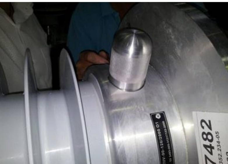
Рис. 10в измерительный вывод с установленным колпаком
